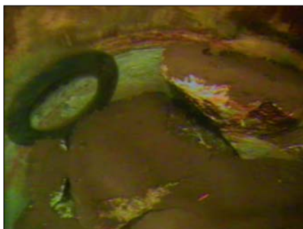
9. ábra. Tömítőgyűrű és betondarab egy ivóvízkút talpán
